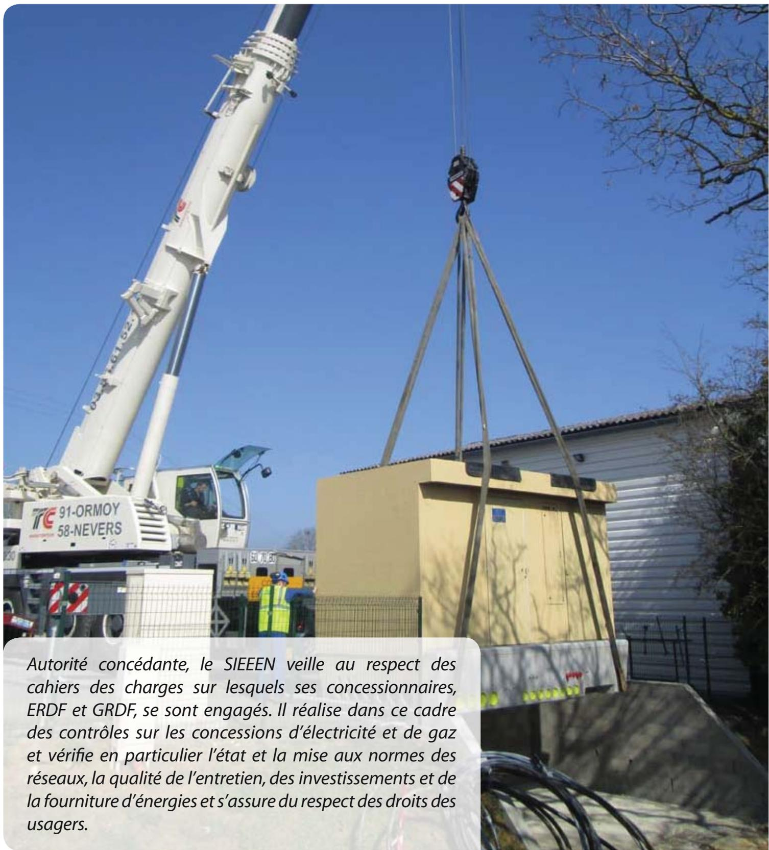
*Autorité concédante, le SIEEEN veille au respect des cahiers des charges sur lesquels ses concessionnaires, ERDF et GRDF, se sont engagés. Il réalise dans ce cadre des contrôles sur les concessions d'électricité et de gaz et vérifie en particulier l'état et la mise aux normes des réseaux, la qualité de l'entretien, des investissements et de la fourniture d'énergies et s'assure du respect des droits des usagers.*
