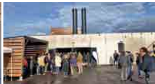
Inauguration de la chaufferie de Varzy Pré L'Évêque
